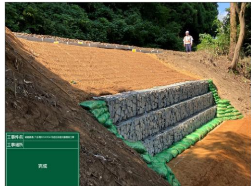
【のり面崩壊 復旧工事完了後】
